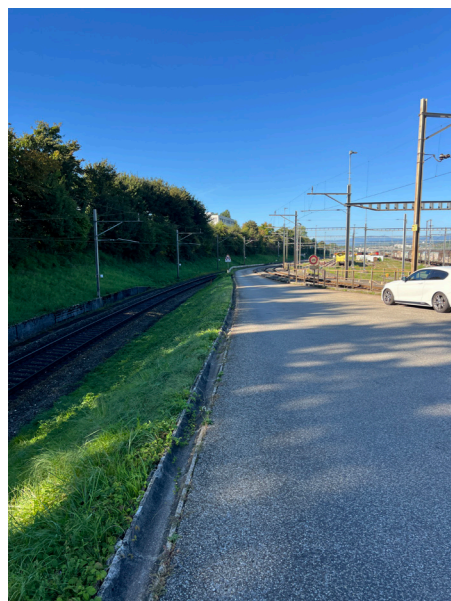
Cunette en béton, dépose et évacuation
