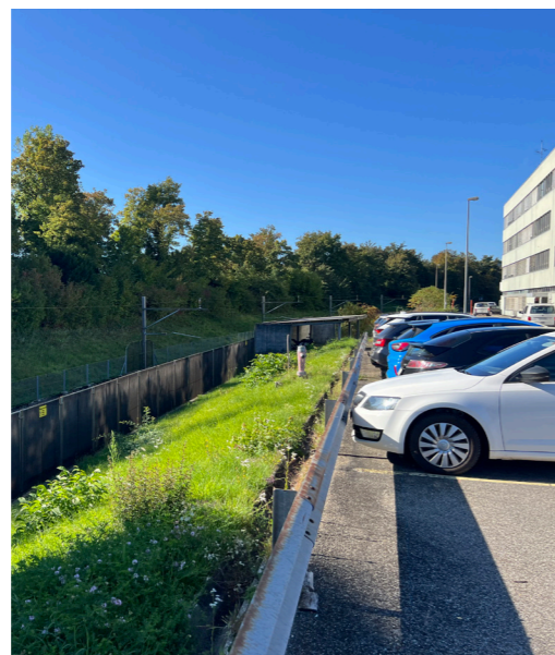
Glissière de sécurité, dépose et évacuation
