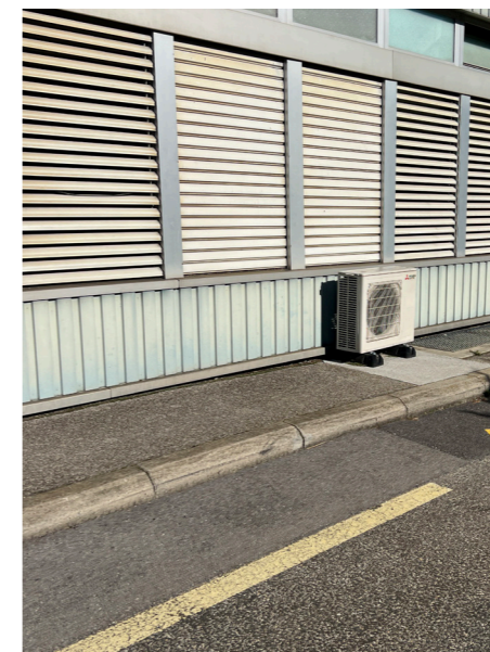
Bordure type État de Vaud, dépose et évacuation
