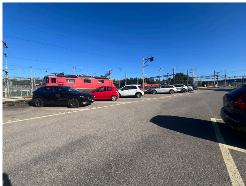
Surface en enrobé, dégrappage
