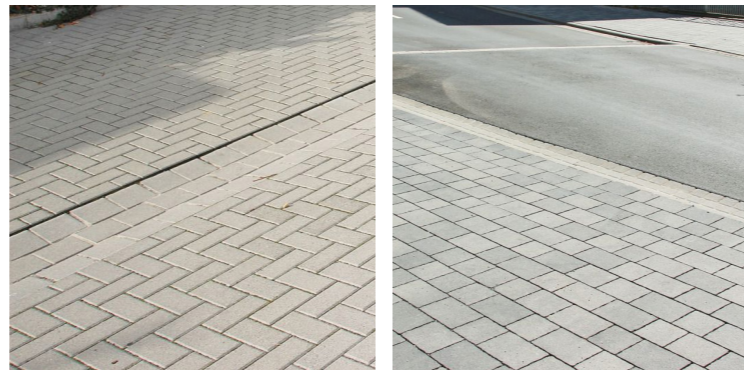
Cunette en pavé
