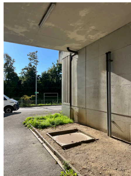
Massif sous terrasse
