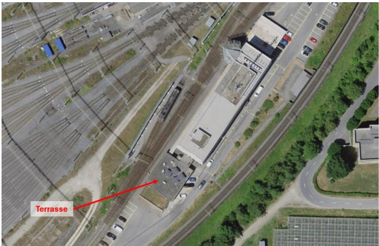
Figure 12. Emplacement de la terrasse au niveau du bâtiment administratif
