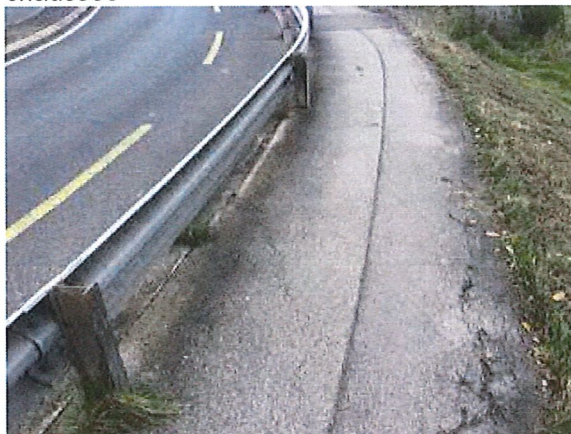
Figure 12 : Rte Gare, Trottoir Est
