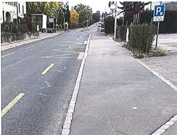
Figure 24 : Arrêt Oches - Quai à rehausser
