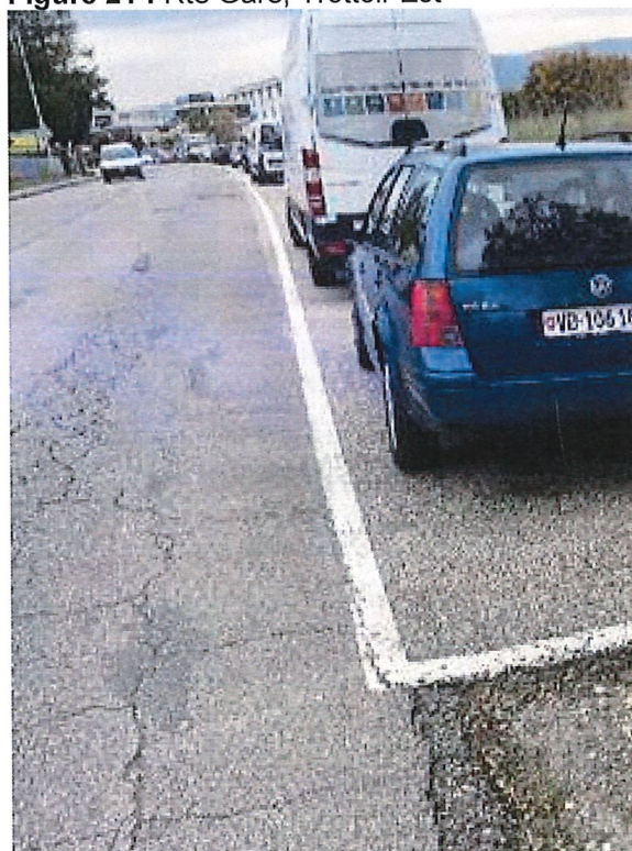
Figure 23 : Rte Préverenges Nord, Zone stationnement
