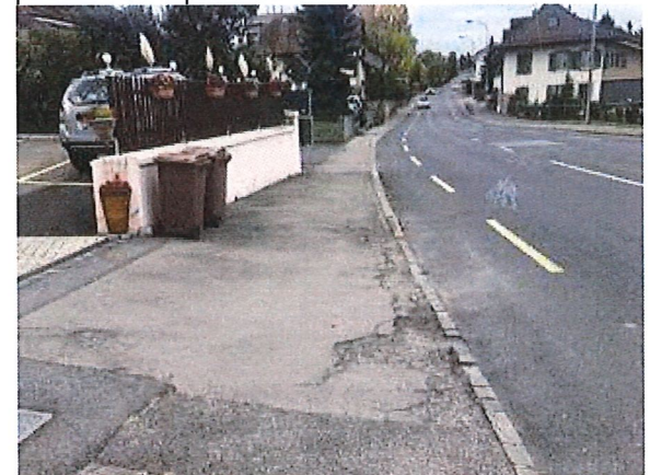
Figure 13 : Rte Gare, Trottoir Ouest
