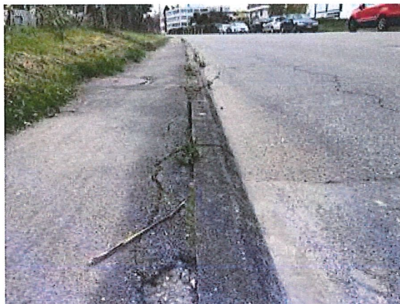
Figure 10 : Rte de Préverenges – Trottoir et chaussée
