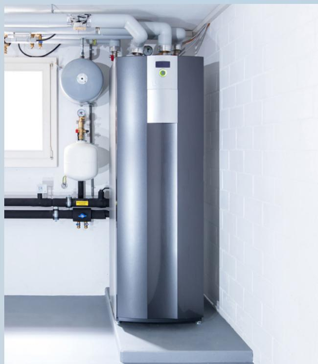
WZSV avec réservoir d'eau chaude intégré de 178 litres
