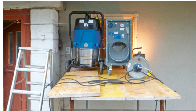
3 Extracteur intégré de façon hermétique dans une fenêtre. Le tuyau de l'aspirateur est passé à travers le système d'étanchéité.
