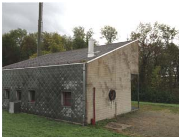
1 Nouvelle cheminée sur toiture en fibrociment amianté
