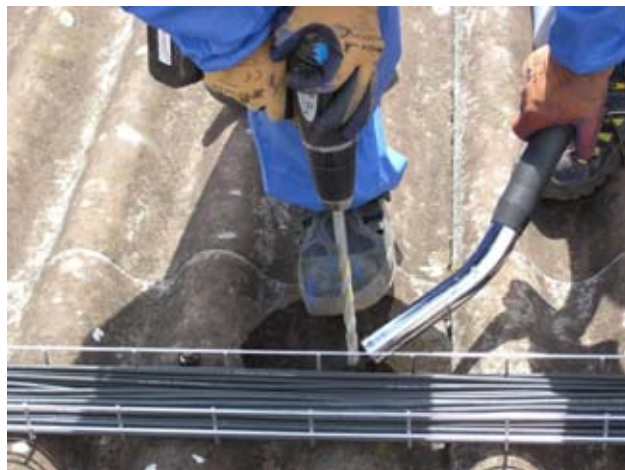
5 Percement en rotation lente, avec humidification et stricte aspiration à la source. Aspirer également sous la toiture.
