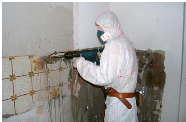
1 Les carreaux comportant de la colle amiantée doivent être enlevés par voie humide avec un perforateur équipé d'un dispositif de pulvérisation d'eau.
