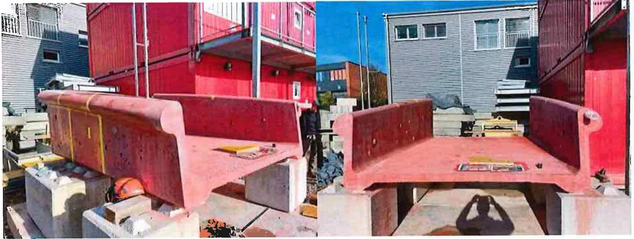
Une fois la procédure de fabrication déterminée avec sûreté, l'opération de construction a pu débuter avec le moulage à l'envers du pont en une pièce sur le terrain de l'entreprise de génie civil à Ecublens.
