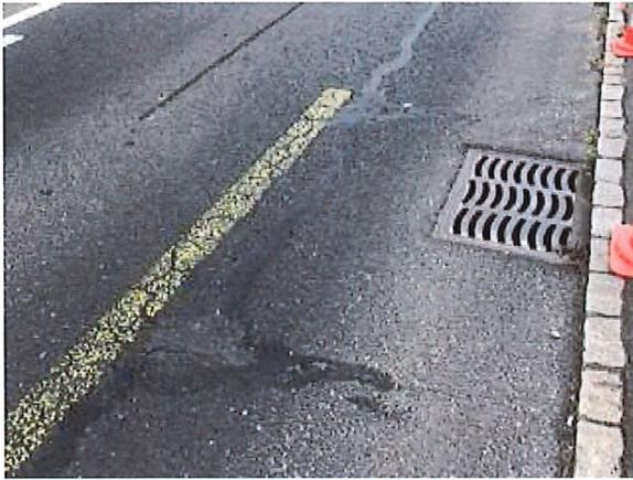
*Figure 15 : Rte Gare, Fissures pontées*
