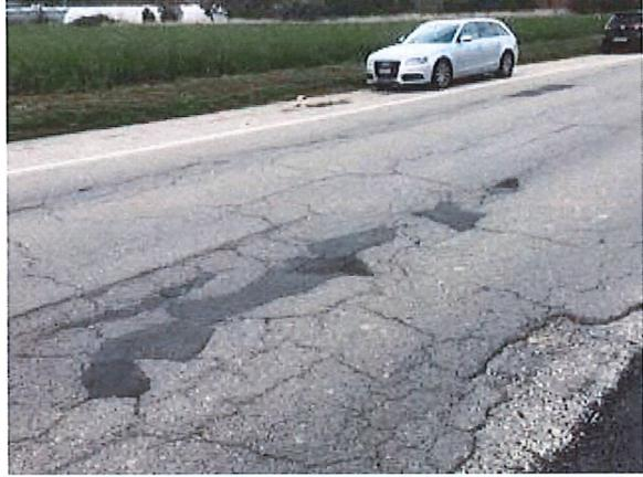
Figure 10 : Rte de Préverenges – Faiçençage pelades et réparations
