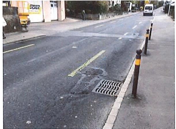
Figure 14 : Rte Gare, Affaissement, faiçençage
