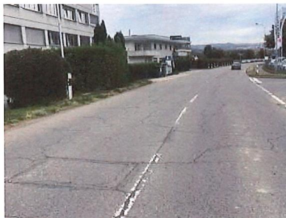
Figure 8 : Rte de Préverenges – Réparations, faiénçage
