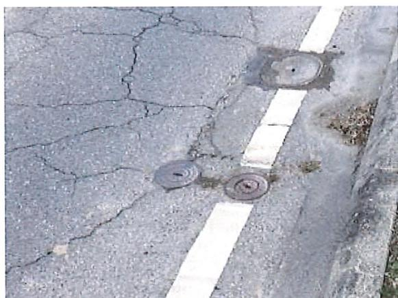
Figure 7 : Rte de Préverenges - Faiénçage
