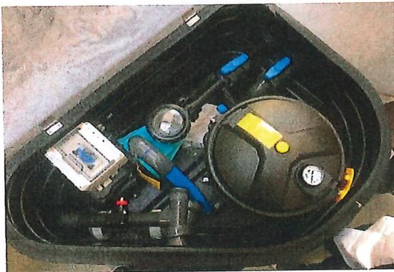
Le filtre à cartouche le coffret électrique, et la pompe de circulation sont logés dans un local enterré sous la forme d'un faux rocher
