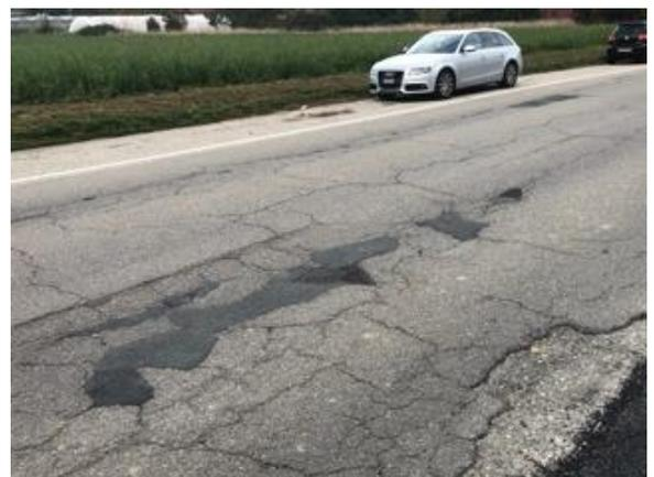
Figure 11 : Rte de Préverenges – Faïençage pelades et réparations
