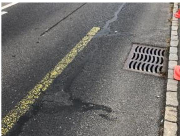
Figure 16 : Rte Gare, Fissures pontées
