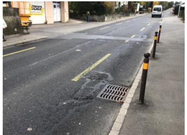
Figure 15 : Rte Gare, Affaissement, faïençage
