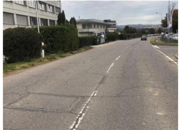
Figure 9 : Rte de Préverenges – Réparations, faïençage
