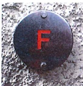
Les tubes feux permettent d'assurer aux sapeurs-pompiers, un accès rapide aux objets sur lesquels ces derniers sont installés. Pour rappel, il s'agit d'un coffre à clé cylindrique dans lequel sont déposées les clés permettant d'accéder rapidement au bâtiment.
